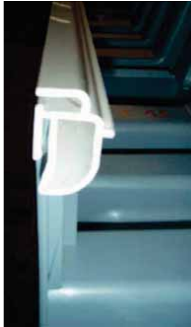
Détail profilé d'accrochage liner
