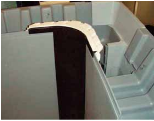
Panneau avec poteau vertical et goulotte de portée de la margelle intégrée
