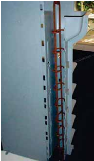
Étrier vertical dans le poteau
