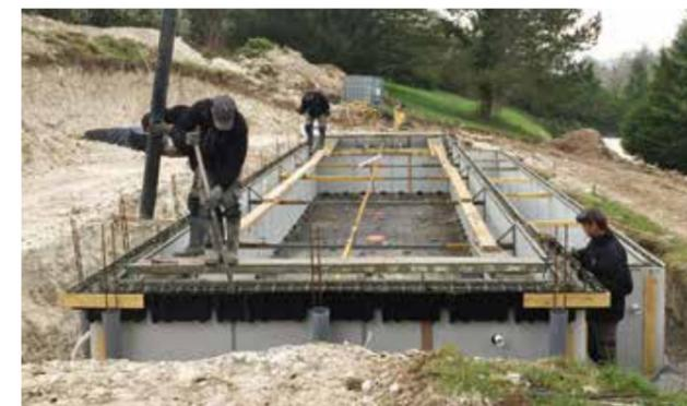
Le béton est coulé dans les panneaux et sur le fond qui a reçu un ferrillage et les pièces à sceller.
