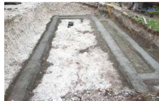
Une fois le terrassement effectué, réalisation d'un béton de propreté et traçage intérieur du bassin 13 x 3,5 m + bac tampon 10 x 1 m.
