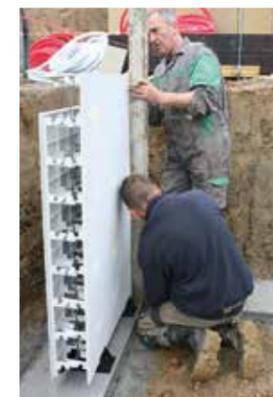
Fixation des sabots, assemblage des panneaux avec rails et chaînage du bassin.
