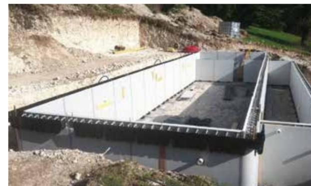
Les panneaux STRUCTURA sont réglés au millimètre grâce aux plots qui les soutiennent. Les rails et support margelles sont assemblés. Les pièces à sceller sont installées mais pas encore raccordées.
